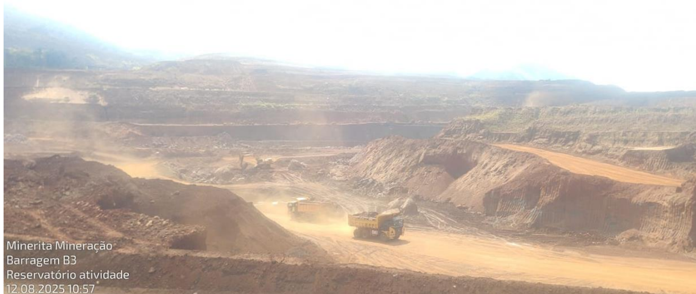
Escavação realizada por conjuntos escavadeiras e caminhões basculantes.
